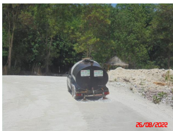
รูปที่ 19 การฉีดพรมน้ำเส้นทางขนส่งแร่
